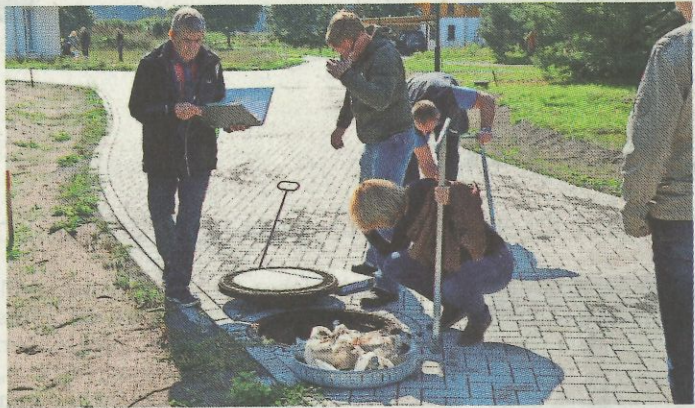
Auch die Schächte wurden genau begutachtet.
